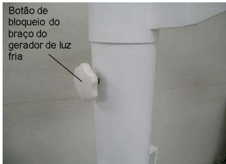
**Figura 9 - Ilustração do botão de bloqueio do braço do gerador de luz fria**
